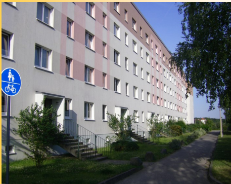
Ansicht zu Beginn der Arbeiten
