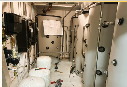
speichern die Wärmeenergie der Sonne: moderne Solarthermieranlagen
