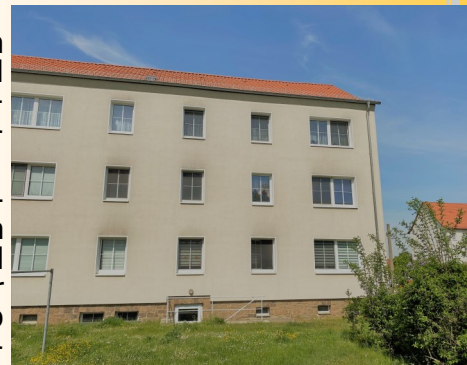
Bald mit Balkonen: Die Nordstraße 1a-b in Brandis
